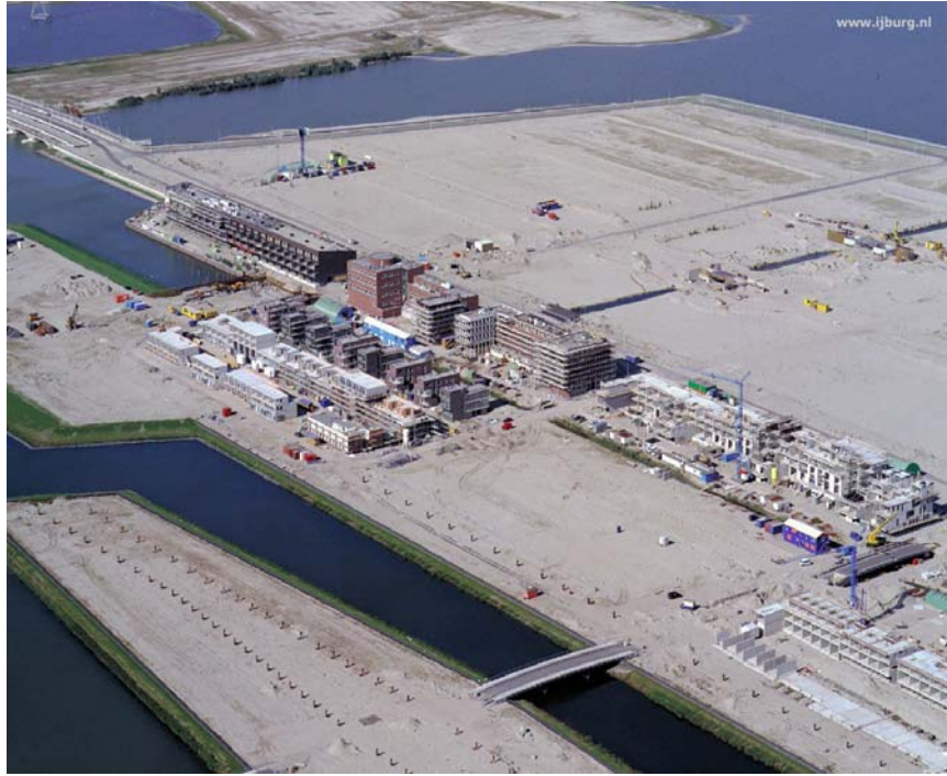
IJburg: Haveneiland West in aanbouw
