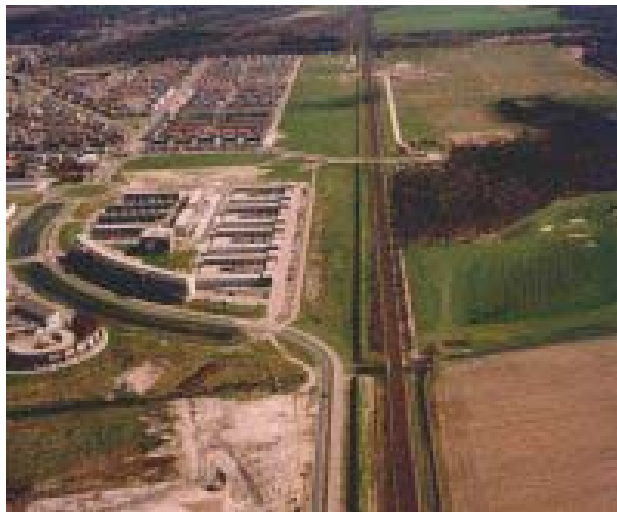
Tilburgs woonwijk Witbrand West in aanbouw met 550 woningen, waarvan 30% goedkope huurwoningen, met verwachte winst van € 12 miljoen (bron foto : www.Tilburg.nl )
